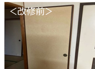
改修工事：指詰め防止
