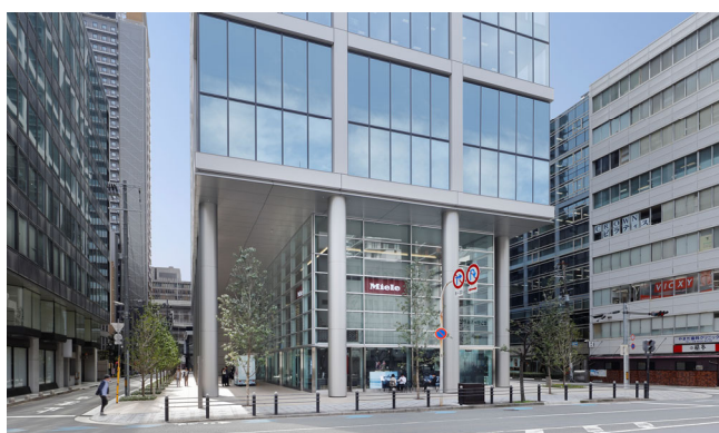
ピロティ全景写真
