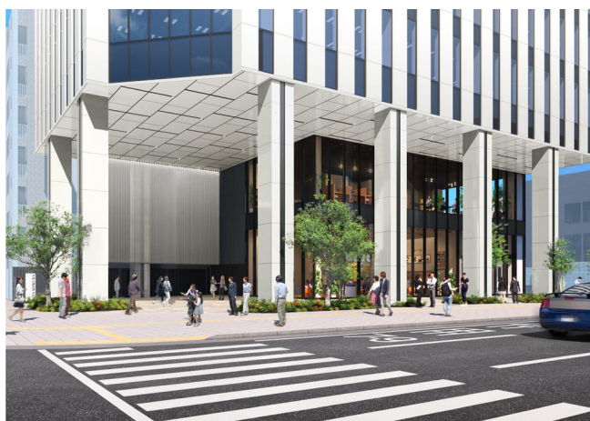
公開空地と建物低層部のピロティ空間
