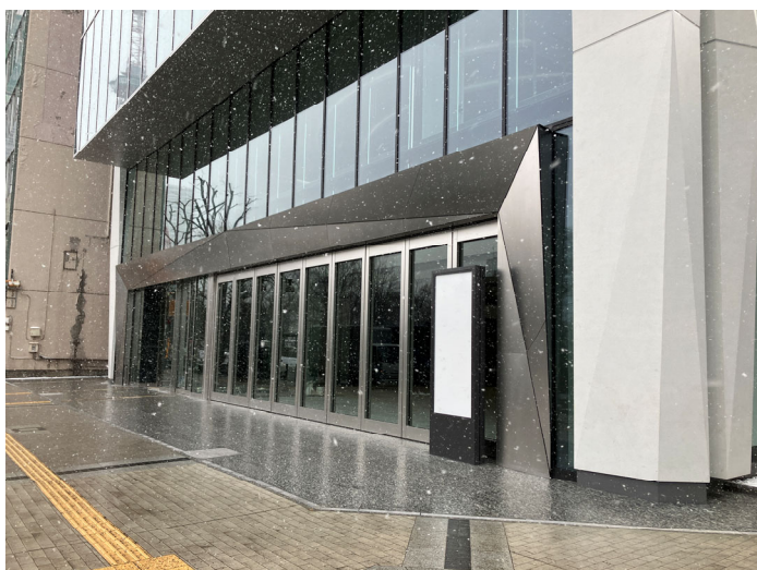
エントランス前の歩道状空地
