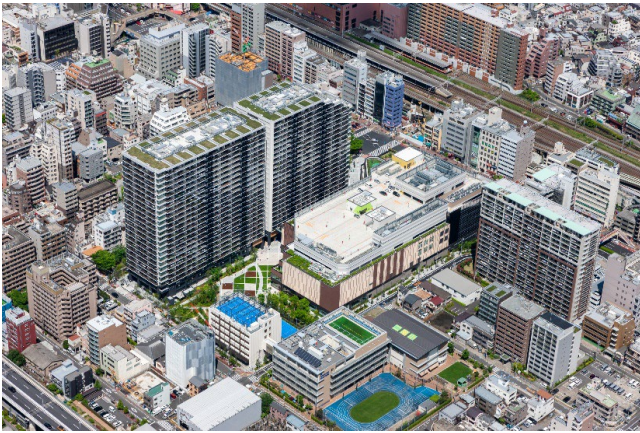
■外観写真 商業棟と住宅棟間の貫通通路部分
