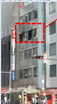
【火災建築物 外観】
