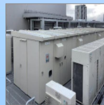
電気設備の設置場所嵩上げ等
