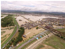
岡山県倉敷市真備町
