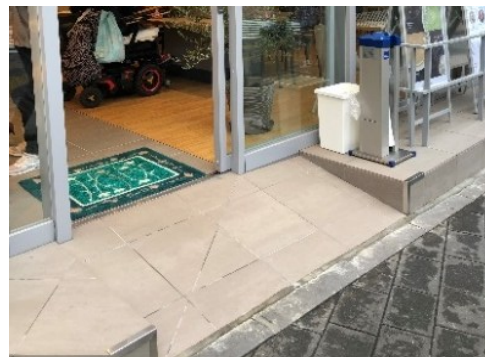
スロープの設置
