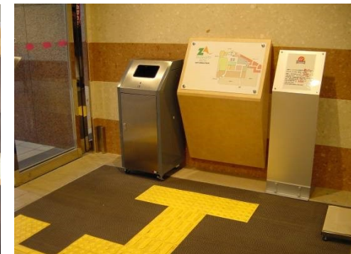
点字ブロック、点字案内板の設置
