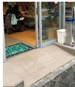
スロープの設置
