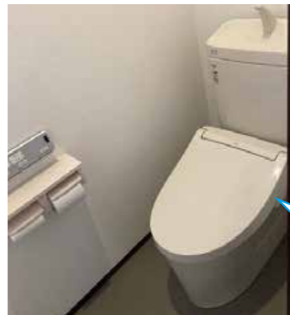
トイレ | 天井・壁への断熱材の設置 ほか
