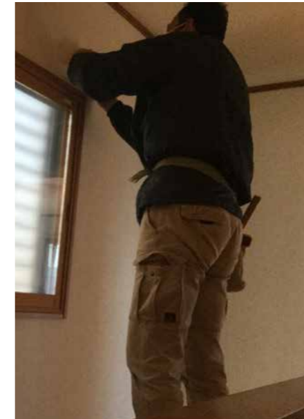
2Fホール | 内装クロス張り替え
