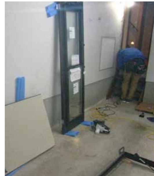
勝手口 | 既存ドア撤去、アルミドア取付
