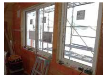
窓改修 | 樹脂サッシへの交換
