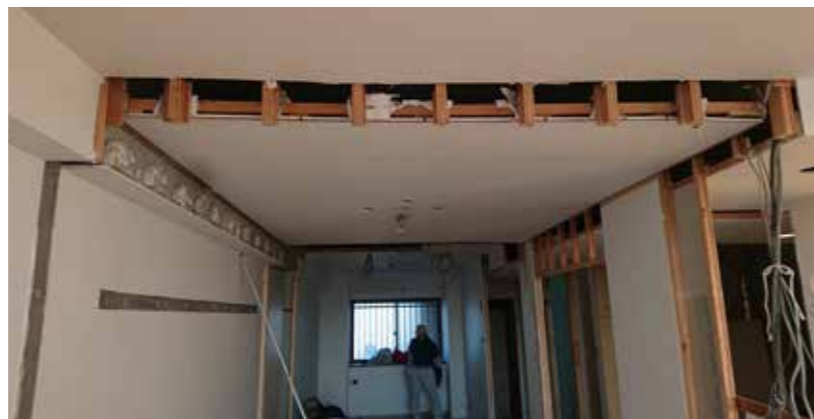
108 施工中[リビングから北洋室]
