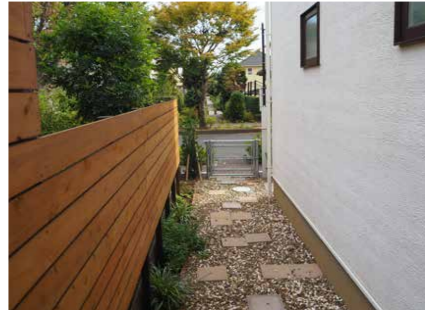
路地庭 | 柵、敷石設置
