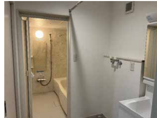
風呂・脱衣場 | 設備取り替え 改修後
