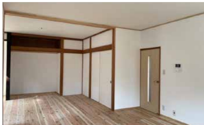
66 リビング | 壁漆喰・床無垢板へ張り替え
