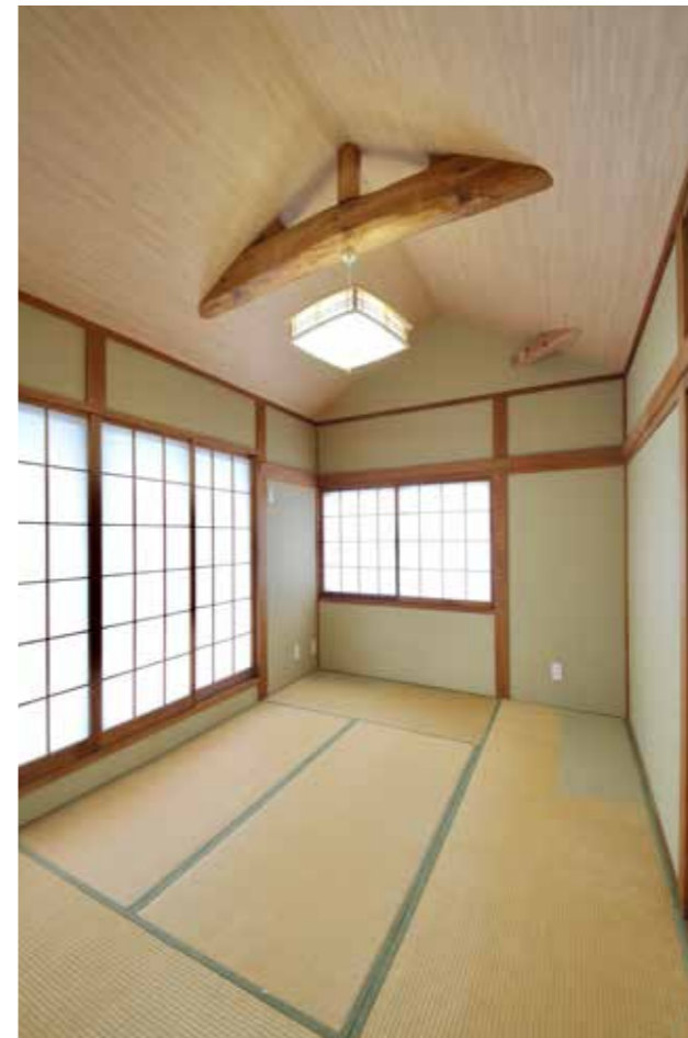
和室 | 畳貼り替え・天井を勾配天井へ
