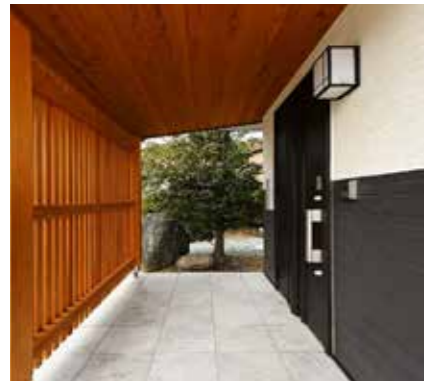
玄関扉 | 交換 外壁 | 張り替え
