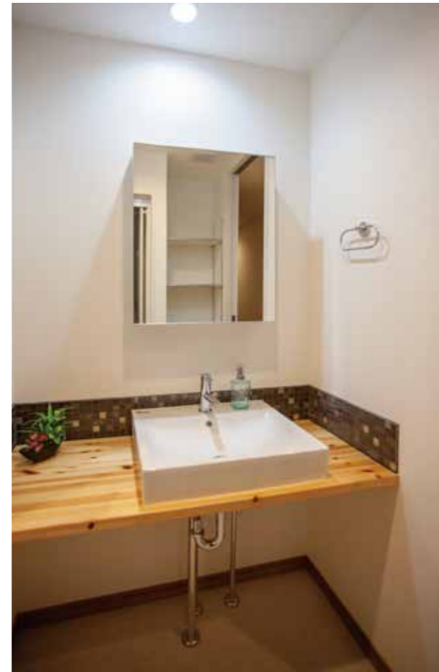
洗面 | 設備交換
