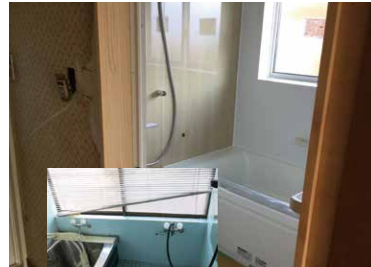
風呂場 | 設備交換 ユニットバスを設置
