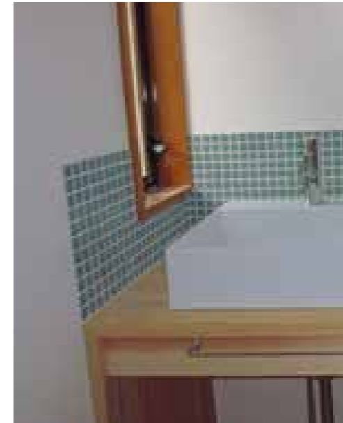
洗面所 | 設備取り替え
