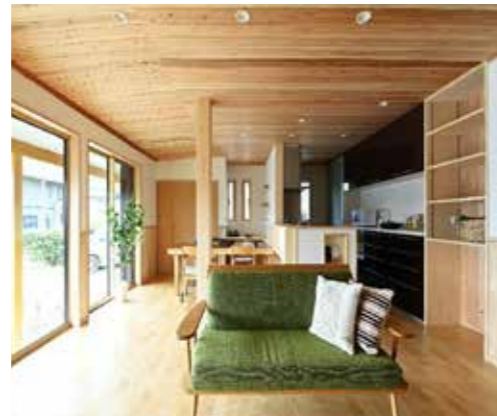
内装 床・壁・天井全面張り替え、サッシ | 交換
