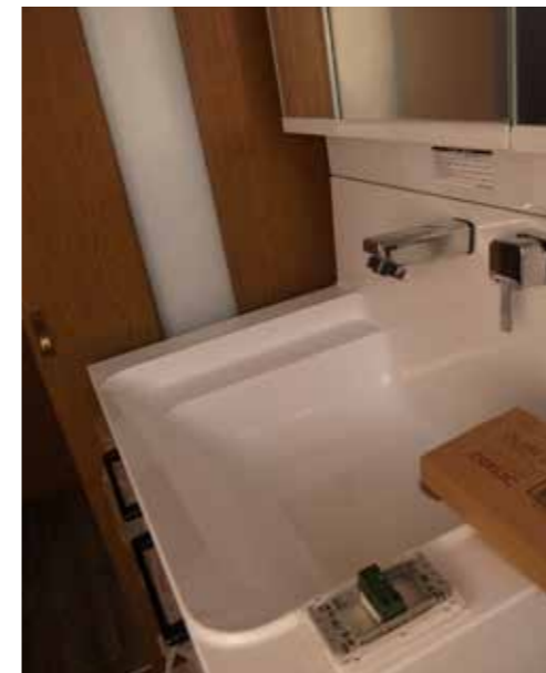
洗面台 | 設備交換
