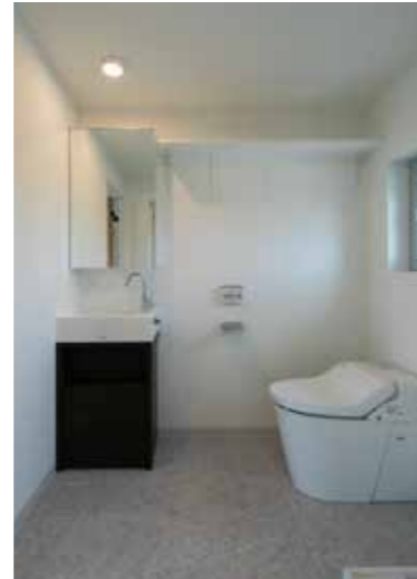
トイレ | 設備取り替え
