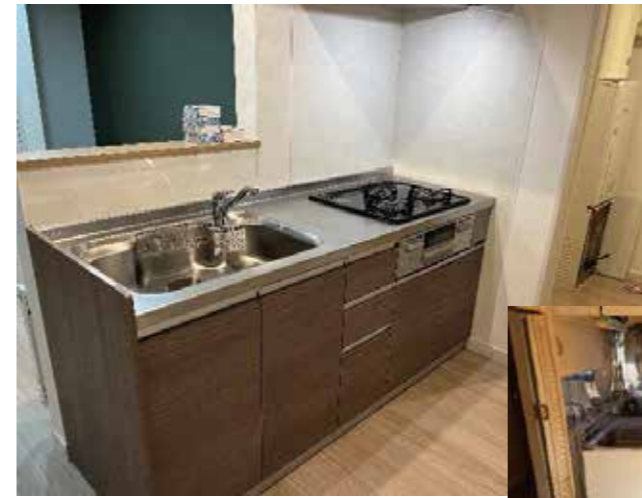
キッチン | 設備取り替え 改修後
