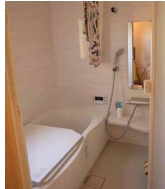
風呂場 | 設備取り替え
