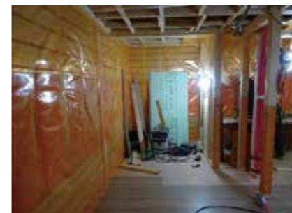
断熱・気密改修 | 断熱材の更新・気密シートの施工
