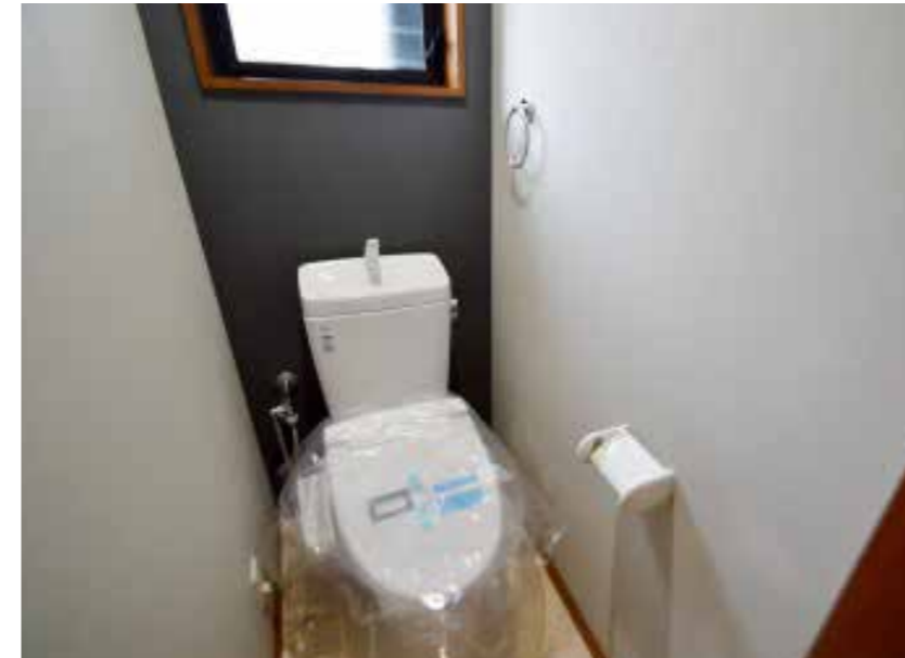
トイレ | 設備交換
