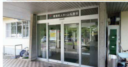
1 高齢者福祉施設では珍しい本格的な体育館。地元民の催し物にも開放している 2 職員棟のエントランス。この階には常にぬれずにも濡れずもあるエントランス内側。入ってすぐ左には受付がある。車椅子用のスロープも完備
