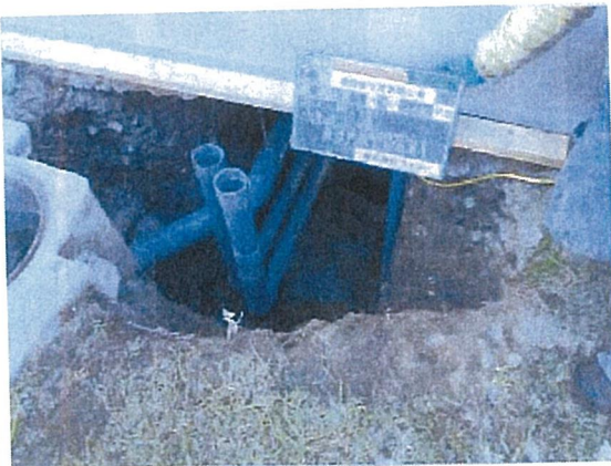
トンネル工法による配管例 1
