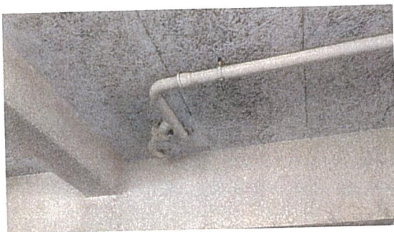
607号室からの排水管状況 1
