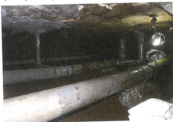
トンネル工法による配管例 2
