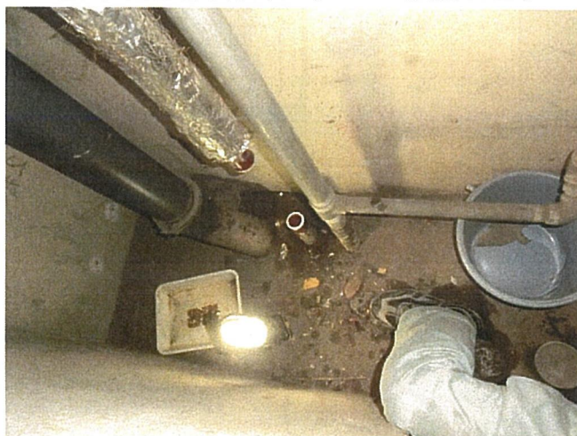
給水管抜管作業 (410 号室 MB)
