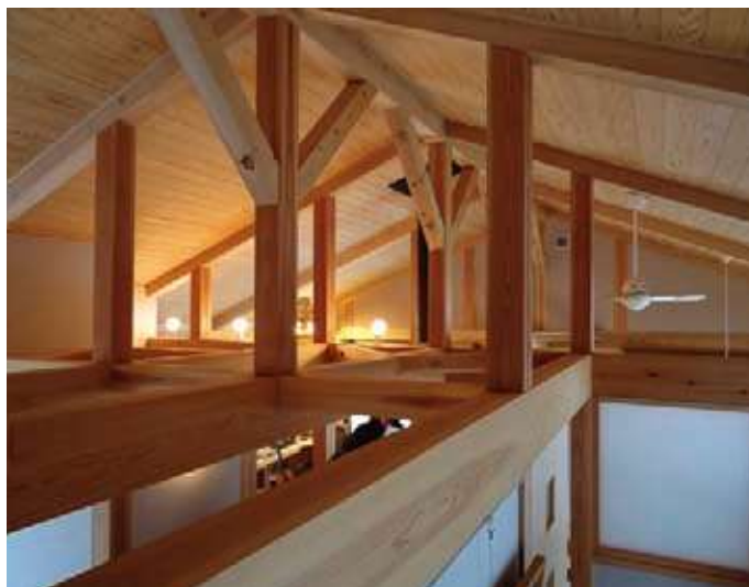
小屋裏現しで天井を高く開放的にし、室内の空気循環をうながす (写真：⑥)
