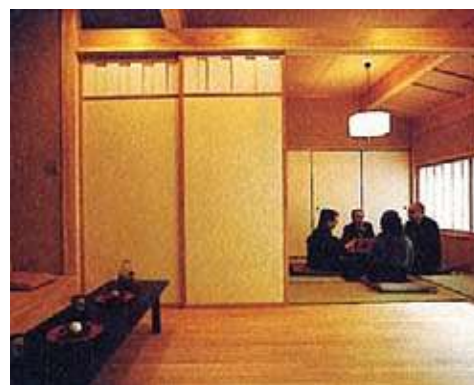
室内の通風のために上部に無双（2枚の板を左右に移動させて開閉する戸）を組み込んだ内部建具（写真：①）
