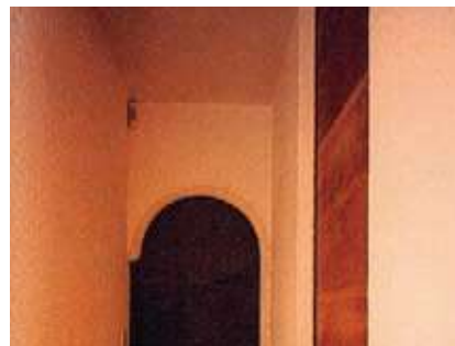
かとうぐち（火灯口）と和紙を用いた壁装。温かさ、柔らかさを感じさせる（写真：①）
