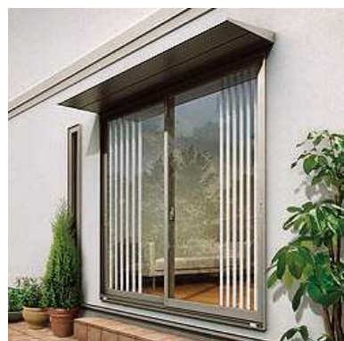
上部に軒庇のない掃き出し窓に取り付けた庇（写真：⑨）
