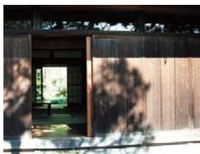
伝統的な民家の雨戸。風雨から開口部を守る戸であるが、防犯、遮音、断熱の機能ももち得る
