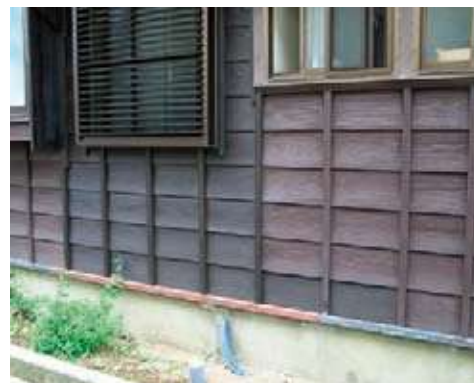
板壁を部分的に張り替えた後に塗装を施す。補修箇所が目立たず全体が馴染む（新潟・和島）
