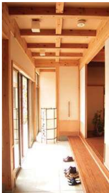
南面の掃き出し窓と窓際の土間。土間床のコンクリートなどは蓄熱性が高い
