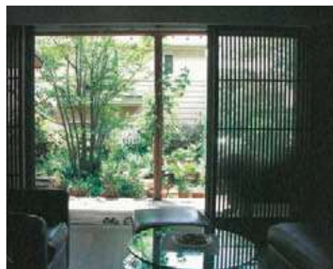
格子戸を締め切ると、風を通しつつ中からは見え、外からは見えない。まぶしさも緩和（写真：①）
