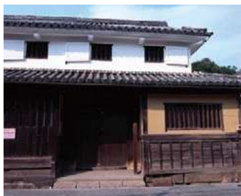
伝統的な民家の漆喰壁
