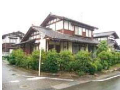
勾配屋根・瓦屋根（富山）
