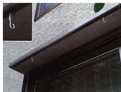
窓庇の先にフック状の金物を取り付け、すだれなどを設けられるようにする (写真：⑧)
