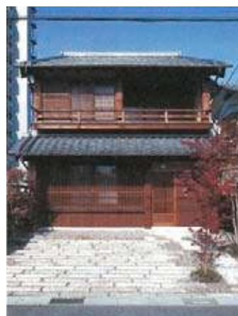
日中は遊び場にもなる住宅アプローチ部分の駐車スペース（写真：①）
