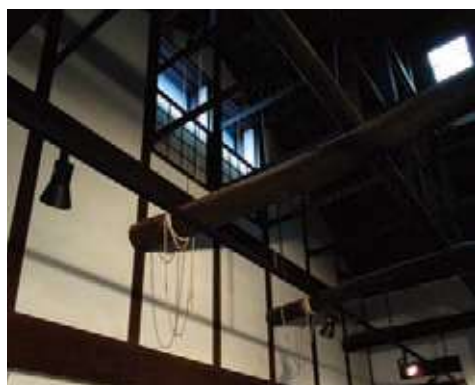
伝統的な町家の土間の採光と換気を確保する高窓と天窓
