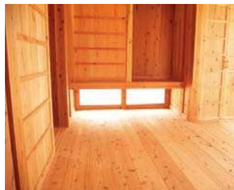
収納下部に設けた換気に配慮した地窓
