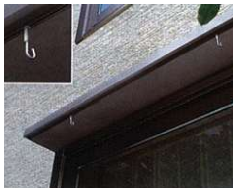
窓庇の先端に、すだれを吊るするためのフックが取り付けられている（写真：②）
