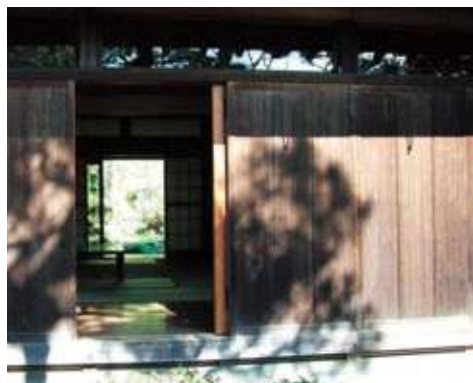
伝統的な民家における板戸の雨戸
