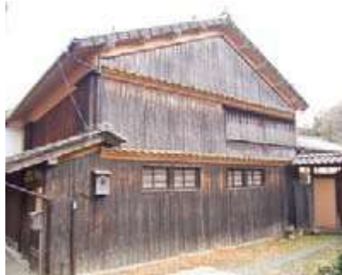
外壁を流れる水を切る水切り瓦 (高知)
