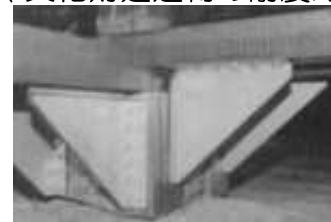
床下ダンパーの設置
