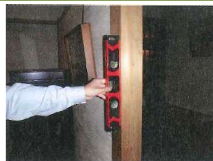
水平器による 柱の傾きの計測
