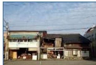
空き家の除却
