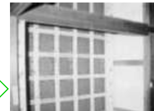
押入れ部分に耐震壁を設置
