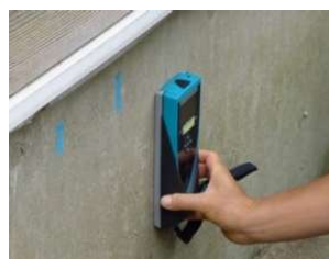
基礎配筋の調査
