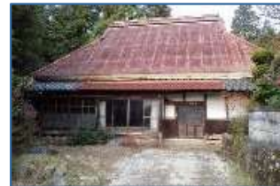
空き家の活用
