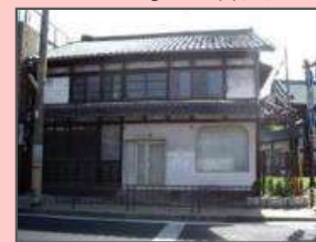
空き家の活用
