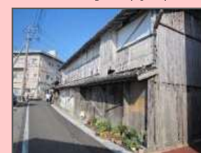
空き家の除却
