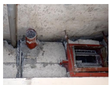
台所換気逆流防止シャッター 風呂釜ダクト外貫通部
