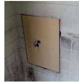
台所換気逆流防止シャッター 風呂釜ダクト外貫通部
