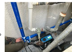
EF接合した高性能ポリエチレン管
