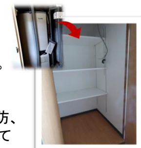
▲撤去した電気温水器置場をパントリーに改修。
