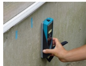
基礎配筋の調査
