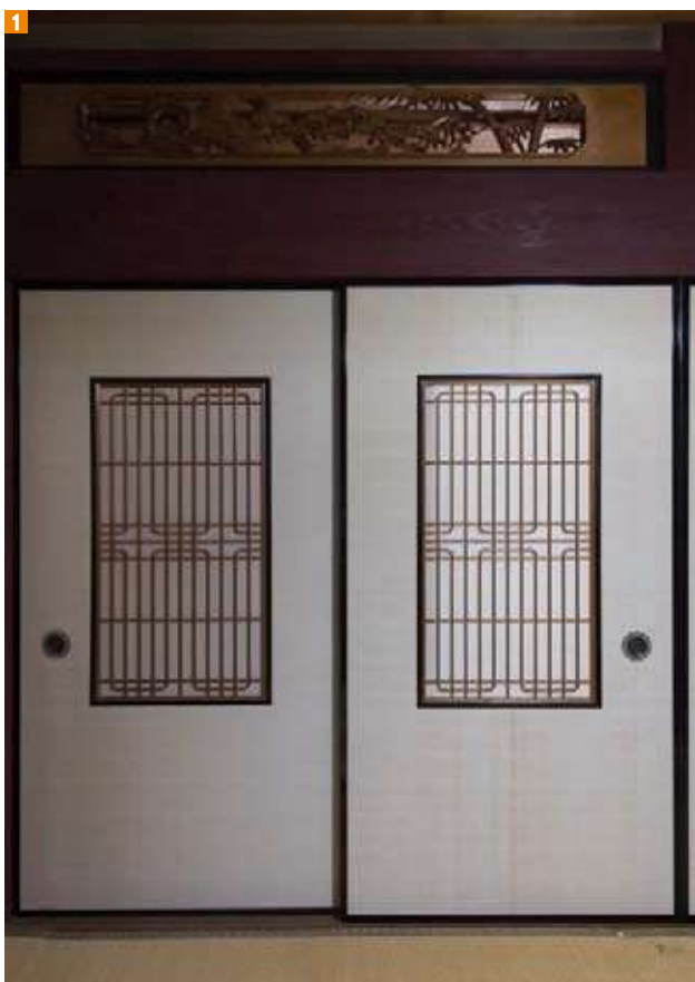
1 室内に光を取り入れ、閉そく感を和らげる襖の一部に障子をはめ込んだ中抜き襖。香道の香図がモチーフ。2 縁側を部屋の外に巡らすことで、部屋を保護し、ゆとりを生む。部屋と縁側を仕切るのは雪見障子。3 写真右手、床の間の脇にあるのは出書院窓
