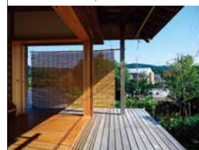
Overhanging eave, veranda and sweep-out door (Kumamoto Prefecture)
