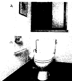
手すりの設置
