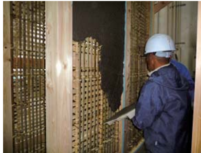
大分の土壁の施工風景
