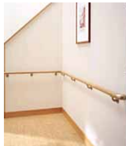
<手すりの設置>
