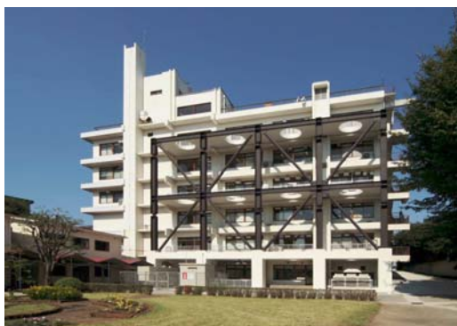
森永乳業耐震補強工事
