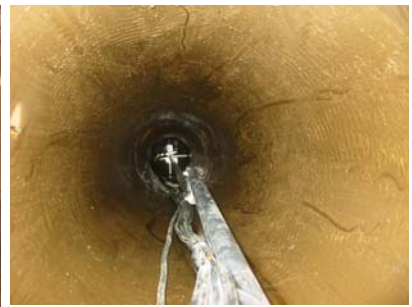
写真4 孔内の健全性試験装置
