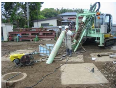
写真2 掘削装置と調査状況
