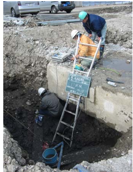
写真1 解体時に実施した調査例
