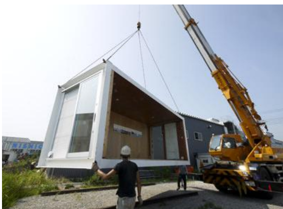
写真3. クレーン吊上げ
