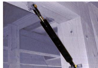
図1 木造用制震ダンパー
