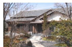
②自宅母屋(改修後)163.1㎡
