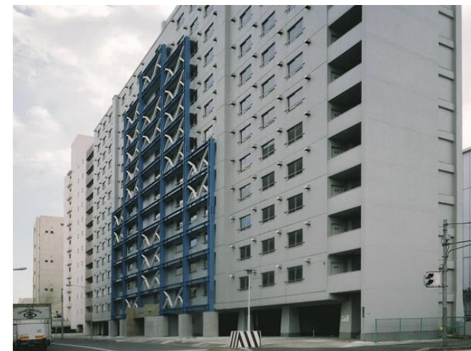
外側耐震補強
