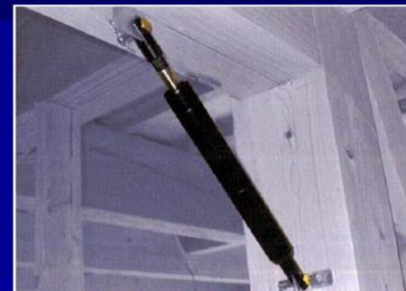
低層鉄骨用DIY制震工法を考案・整備する
