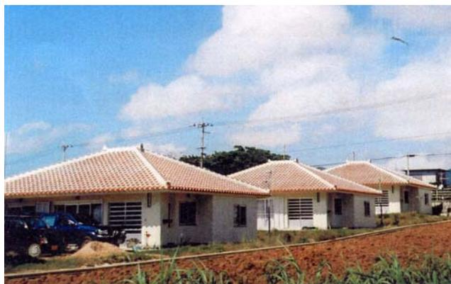
伝統的な赤瓦と長い庇により通風性を良くし、南国特有の気候に適するよう工夫（沖縄県石垣市）
