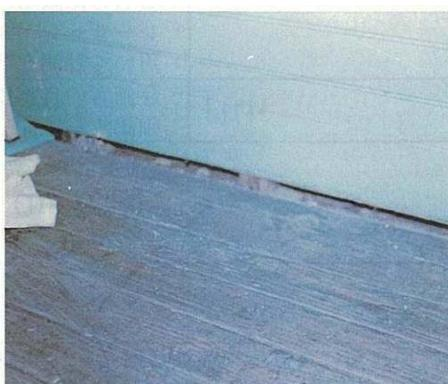
「床の傾斜」が想定される床・壁取り合い部の間隙
