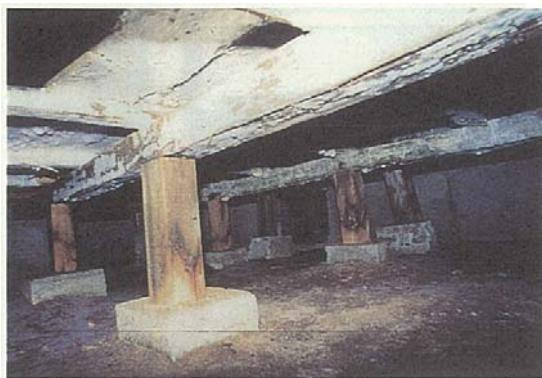
床下部分の腐朽
