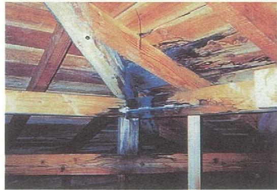
小屋裏の雨漏り部分の腐朽
