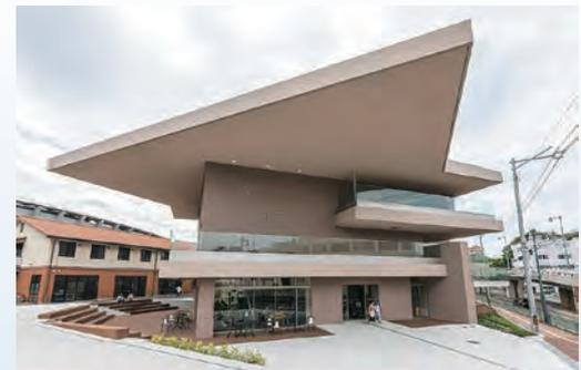
●梅光学院大学 The Learning Station CROSS LIGHT 所在地/山口県下関市向洋町 主用途/大学 構造/鉄骨造 階数/地上3階 敷地面積/1万7876.52㎡ 建築面積/1990.09㎡ 延べ面積/3873.5㎡ 発注者/梅光学院 設計・監理者/小堀哲夫建築設計事務所 施工者/清水建設 施工期間/2018年4月~19年3月 開館日/2019年4月1日
