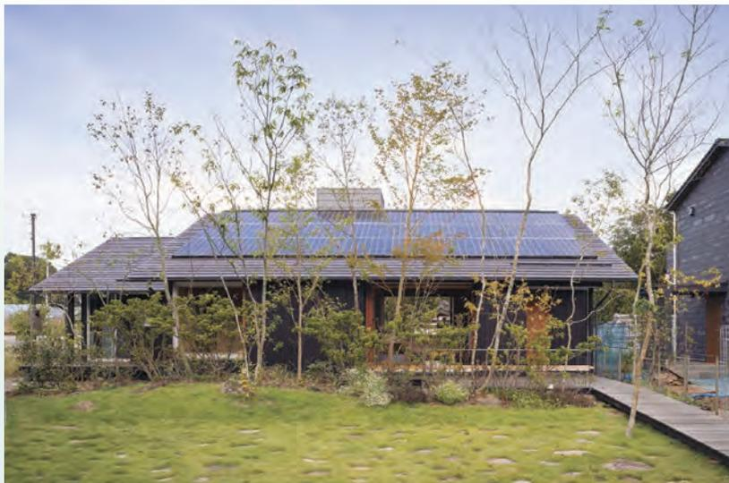
● 里山の平屋暮らし 構造/木造在来工法 階数/地上2階 建築面積/109.43㎡ 施工面積/132.00㎡ 延べ面積/120.43㎡ 1階床面積/102.26㎡ 2階床面積/18.17㎡ 主たる居室の面積/39.66㎡ その他の居室の面積/26.03㎡ 非居室の面積/79.32㎡ 設計者/伊礼智設計室 施工者/柴木材店 温熱コンサルタント/東京大学大学院前真之研究室(劉行、大平豪士、山本遼子、溝口暉人) 完成/2019年6月
