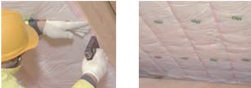
写真 5.6.1 屋根の充填断熱
