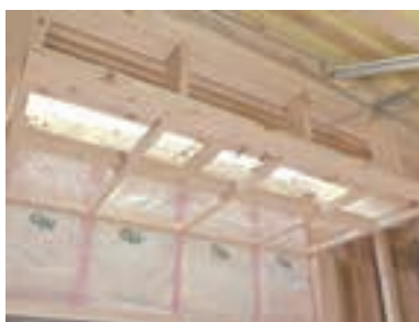
写真 5.7.1 下屋部分の断熱施工前
