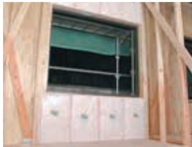
写真 5.4.1 開口部まわりの断熱施工
