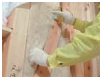
写真 5.3.4 筋かい部分の断熱材の施工
