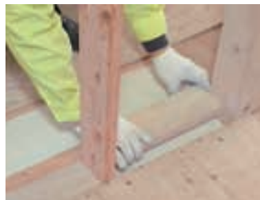
写真 5.2.5 間仕切り壁の下部の気流止め
