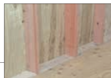
写真 5.2.4 乾燥木材による気流止め
