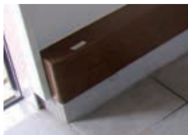
図 5.1.10 基礎内断熱の場合の内装の配慮
