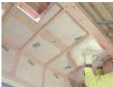
写真 5.7.2 下屋の天井断熱
