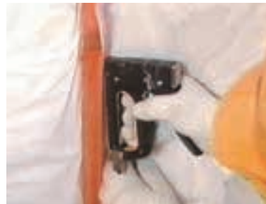
図 5.3.9 防湿フィルムの施工の悪い例 - 1
