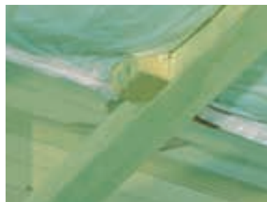
写真 5.5.3 別張り防湿フィルムの施工
