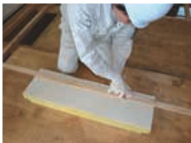
写真 5.2.1 断熱材の切断と施工
