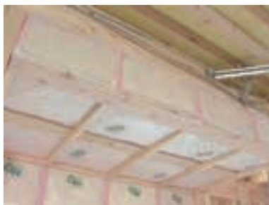
写真 5.7.4 断熱材の施工が完了
