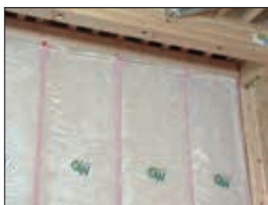
写真 5.3.2 繊維系断熱材の施工
