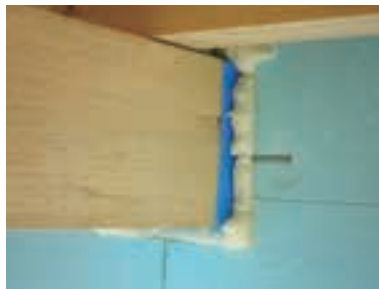
写真 5.3.5 貫通部の断熱補強
