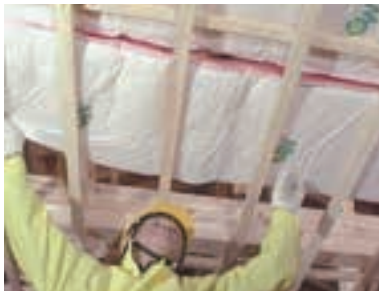
写真 5.5.2 天井の断熱材の施工
