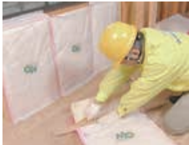
写真 5.3.1 繊維系断熱材の切断
