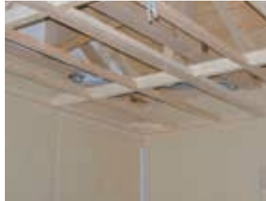
写真 5.5.1 天井の野縁の施工
