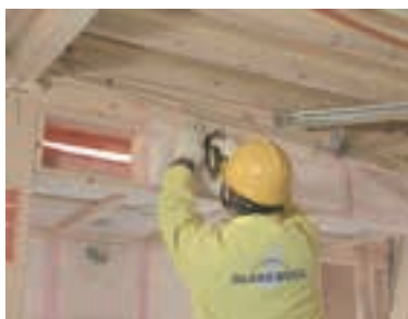
写真 5.7.3 下がり壁の断熱
