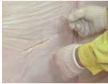
写真 5.3.3 防湿フィルムの補修
