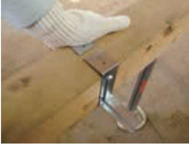
写真 5.2.2 断熱材受け専用金物
