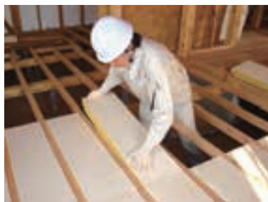
写真 5.2.1 断熱材の切断と施工
