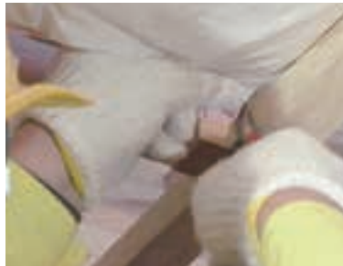
写真 5.5.2 天井の断熱材の施工
