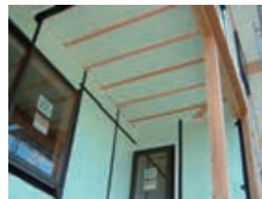
写真 5.2.7 外壁と軒天の断熱
