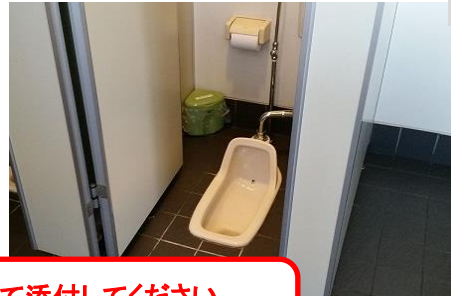
【改修する便器写真】(改修の場合は必須)
