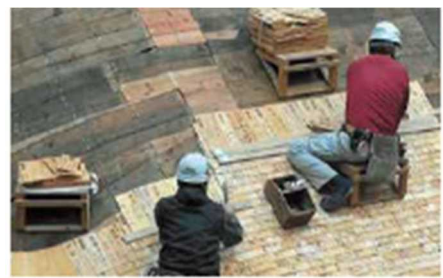
奉納された土居葺板を屋根下地に （同左）
