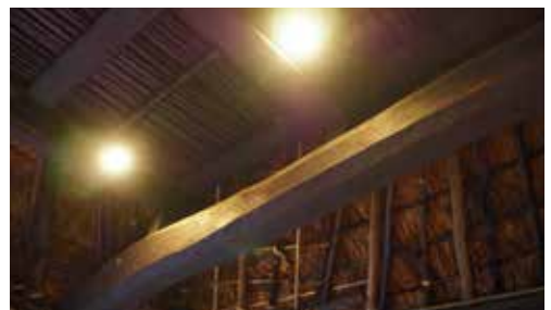
茅葺屋根の家に泊まる (兵庫県丹波篠山市集落丸山)
