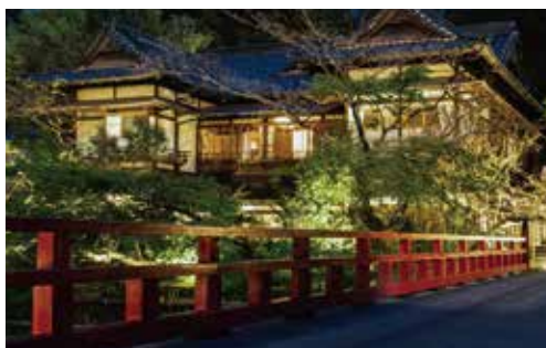
再生後に登録有形文化財に指定された旅館 (神奈川県湯河原町)
