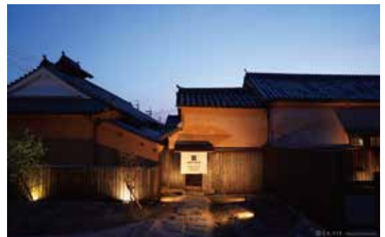
兵庫県指定文化財「大庄屋 三木家住宅」の一部を改修・活用した、「NIPPONIA 播磨福崎 蔵書の館」の外観 ©LA-VIE PHOTOGRAPHY
