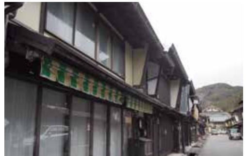
実現に10年をかけた電線の地中化(岐阜県郡上市八幡町)
