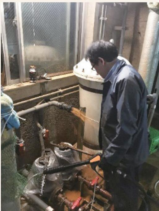
▲設備メンテナンスの様子（温泉のろ過器配管洗浄）
