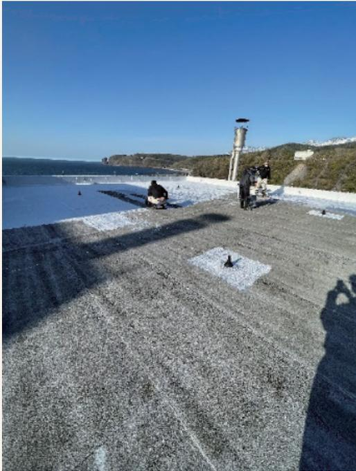
▲設備メンテナンスの様子（防水処理作業）
