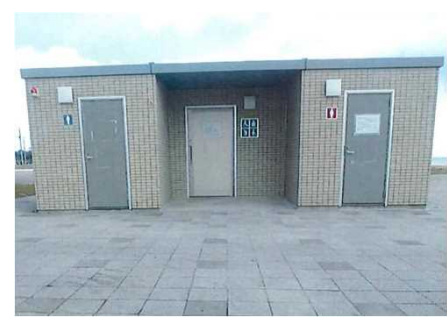
段差を解消したトイレ棟
