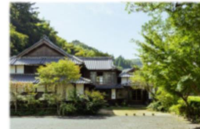
受入拠点の改修
