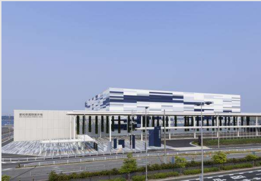
対象施設の外観
