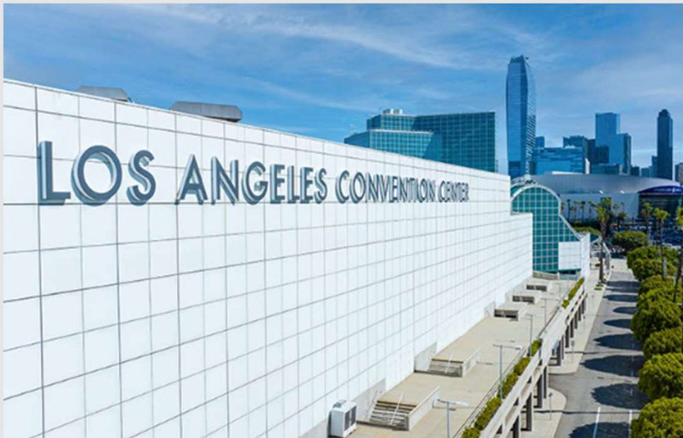
対象施設の外観
