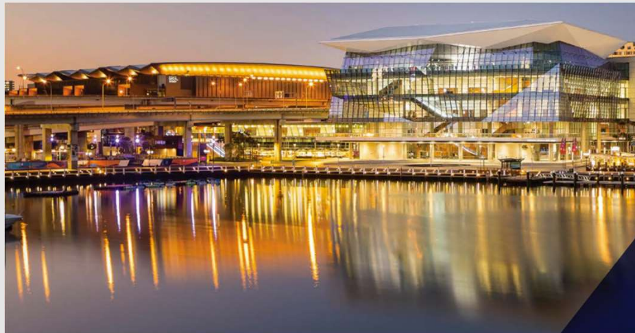
対象施設の外観
