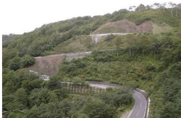
▲国道102号七曲区間のつづら折り区間
