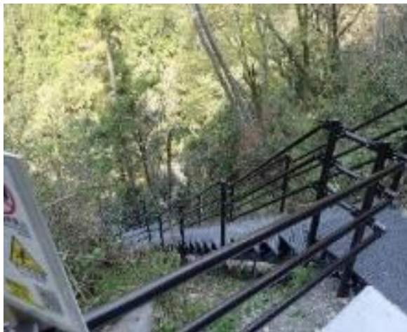
既存の階段（傾斜が急で幅が狭い）
