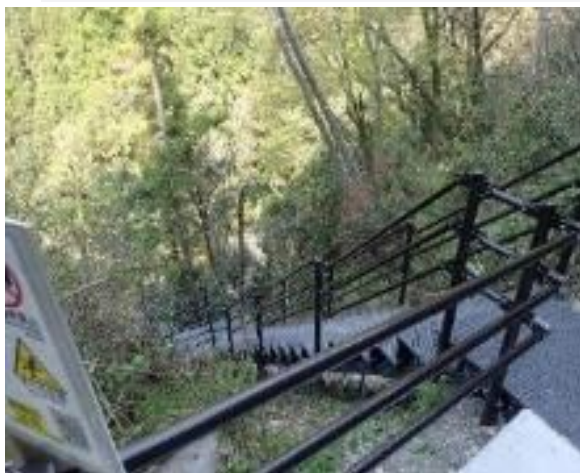
既存の階段（傾斜が急で幅が狭い）
