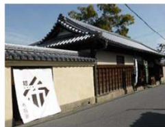
(例)歴史的建造物の修理・買取
