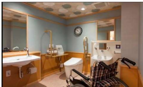
客室トイレのバリアフリー化
