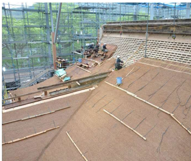
維持修理 重要文化財 大宰府天満宮本殿 屋根葺替えの様子（福岡県）
