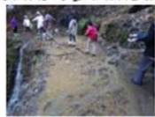
(利用が多い荒廃歩道の再整備)
