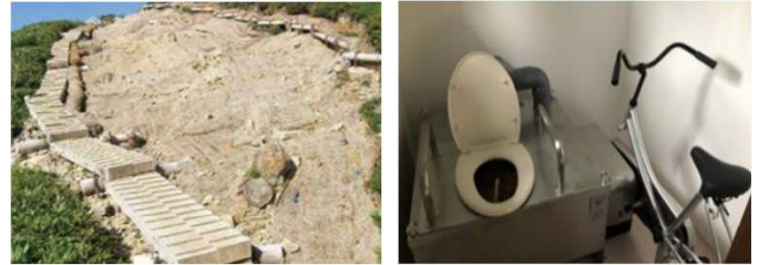
自然保護のための遊歩道の整備
