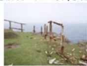
(老朽化した落下防止柵の再整備)
