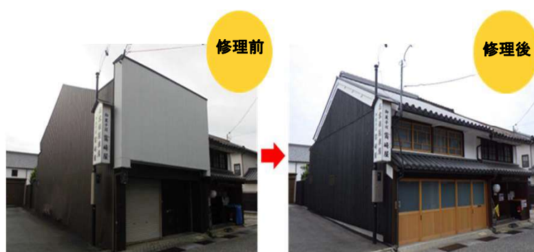
たつの市龍野町伝統的建造物群保存地区の修理事例
