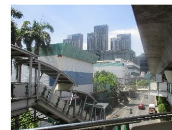
地下鉄駅から雨に濡れず行ける。
