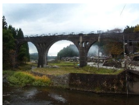
歩道化された線路跡や 橋梁
