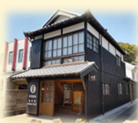
＜佐賀県 壺野市塩田津＞ 公開活用施設
