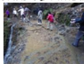
(利用が多い荒廃歩道の再整備)
