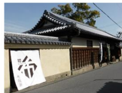
(例)歴史的建造物の修理・買取
