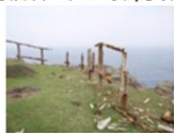
(老朽化した落下防止柵の再整備)
