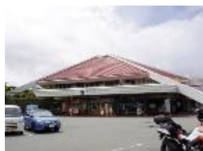
瀬の本高原の商業施設
