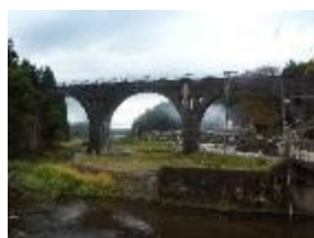
歩道化された線路跡や 橋梁
