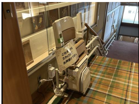
段差がある際の 対応状況を確認
