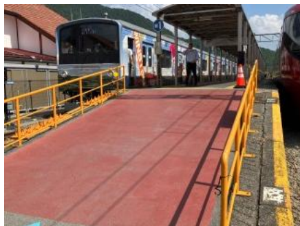
動線に段差がないか確認
