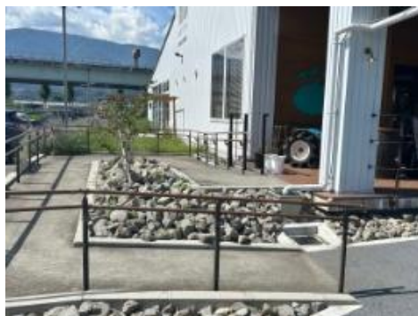
段差の有無を確認
