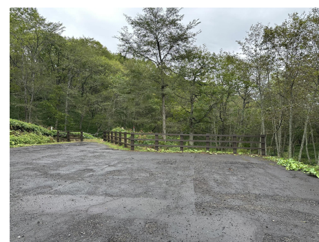
宮島岬に向かう道の入口に侵入防止を目的とした木柵を設置
