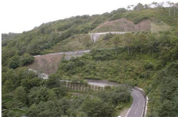
▲国道102号七曲区間のつづら折り区間
