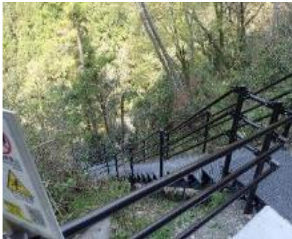
既存の階段（傾斜が急で幅が狭い）
