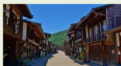
通过修缮历史资源、电杆埋入 地下、街景美化等完善街区风貌
