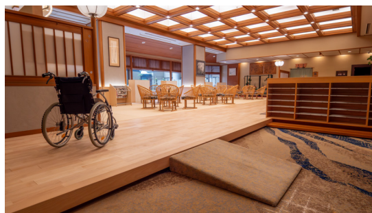
男女大浴場入口(共用サロン前)に、可動式スロープを設置。
