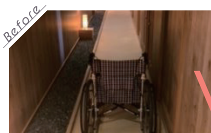
改修前の通路は車椅子の幅ぎりぎりのため、すれ違いが困難だった。
